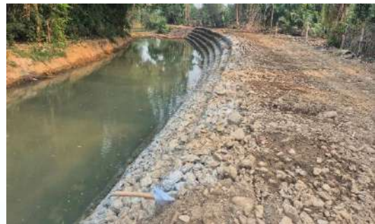
โครงการซ่อมแซมผนังป้องกันตลิ่งพัง ลำน้ำและ บริเวณซอย 1 (บ้านมอญ)
