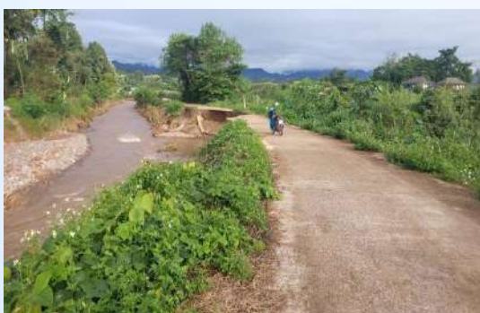
โครงการซ่อมแซมถนน คสล. เลียบลำน้ำและ พร้อมซ่อมแซมผนังป้องกันตลิ่งพัง ฝั่งบ้านมอญ (บ้านมอญ)
