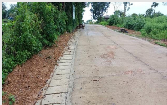
โครงการก่อสร้างรางระบายน้ำ คสล. ชนิดถ้วย แบบมีฝาปิด (บริเวณข้างสวนนายสรศักดิ์ น้ำตอง) (บ้านทุ่งช้าง)
