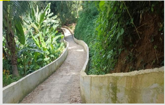
โครงการก่อสร้างทางเดิน คสล. พร้อมผนังกันดิน คสล. (ทางลงซอยข้างบ้านนายคมศิลป์ คำซัง – ลำน้ำเลียบ) (บ้านแพะกลาง)
